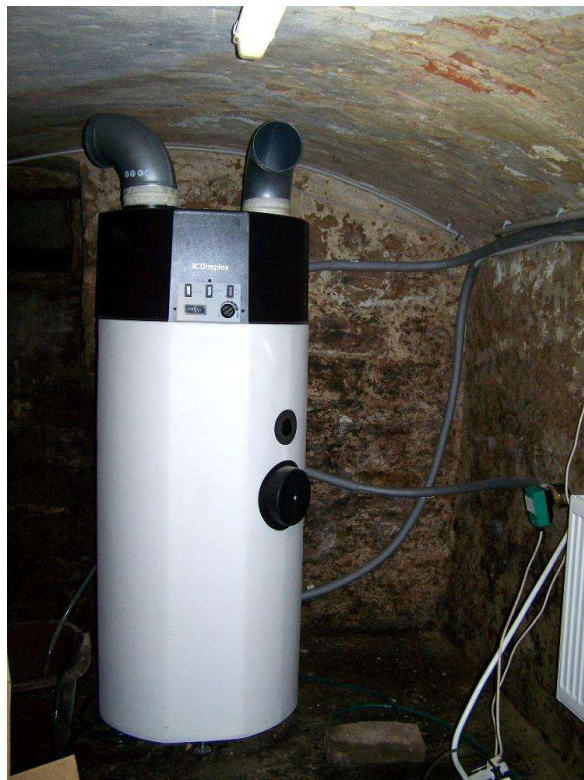
Luft- Wärmepumpe
